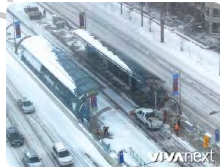
Photo 5.2 Entretien d'une station SRB à Markham, Ontario 43
